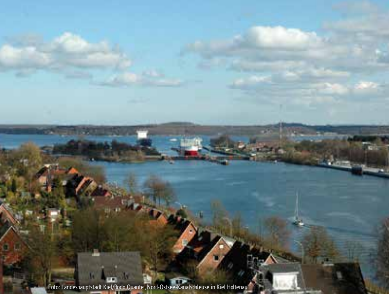
Foto: Landeshauptstadt Kiel/Bodo Quante, Nord-Ostsee-Kanalschleuse in Kiel Hottenu
